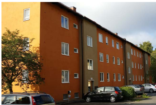
Fastigheterna i Norrby och Brickbandet byggdes i början av 1940-talet
